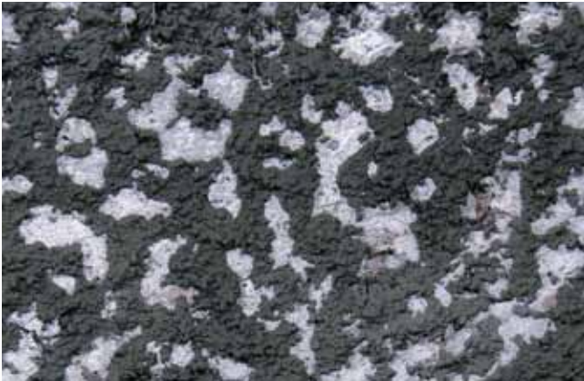
Ondergrondvoorbehandeling met spatlaag PCI Saniment HA
