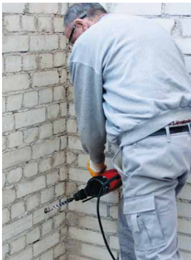
Het boren van gaten voor de horizontale afdichting
