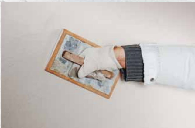
Nabehandeling van de wand met fijnkorrelige afwerkpleister PCI Saniment FP
