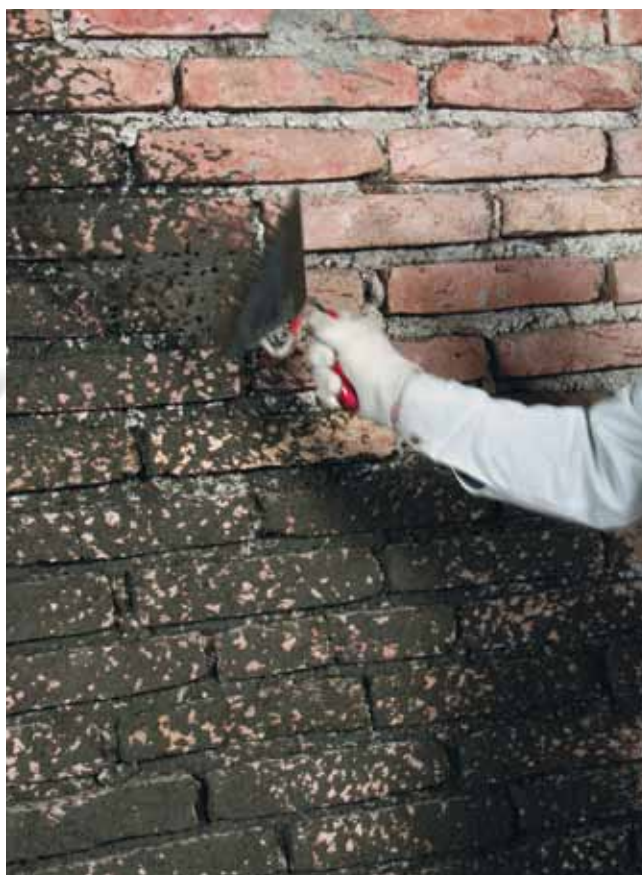
Aanbrengen van spatlaag PCI Saniment® HA, 50% dekking, met spaan
