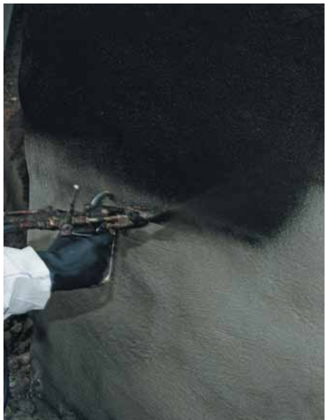
Grondering van de kelderbuitenmuur met PCI Pecimor® F voor de afdichting
