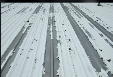
Afbladderende gevelcoating
