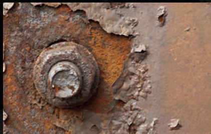
Geroeste stalen constructie?
