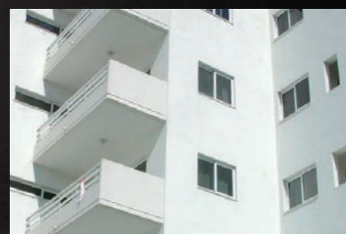
Waterdichting van buitenmuren
